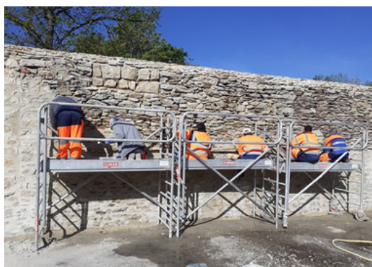
Chantier d'avenir, photo Laval Agglomération
